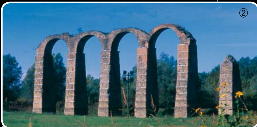
① e ② Gli archi dell'acquedotto romano The arches of the Roman aqueduct
